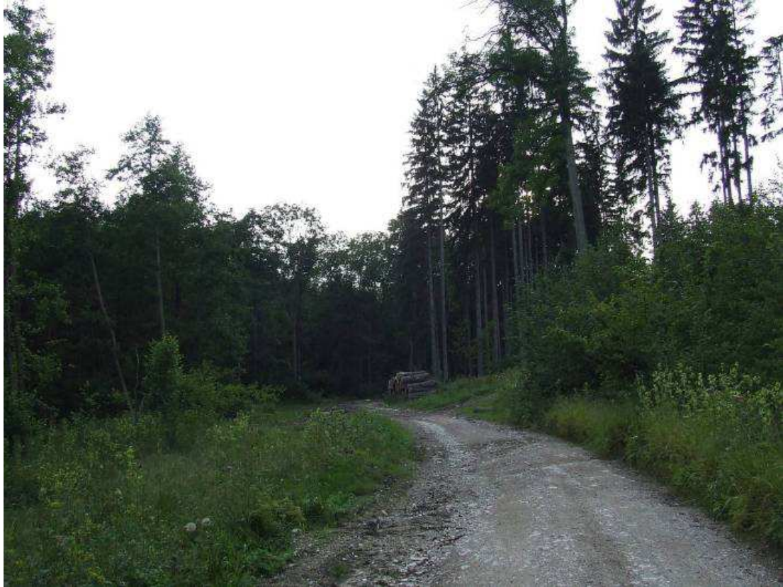
Fot. 1. Widok na drogę przewidzianą do remontu, na granicy działek 202/361 i 203/360; 13.08.2011 (fot. T. Zajac)
