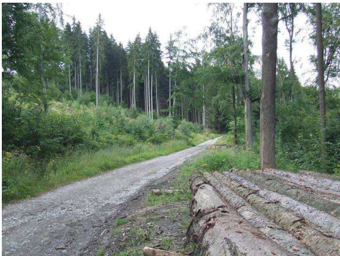
Fot. 4. Widok na drogę przewidziana do remontu; 13.08.2011 (fot. T. Zając)
