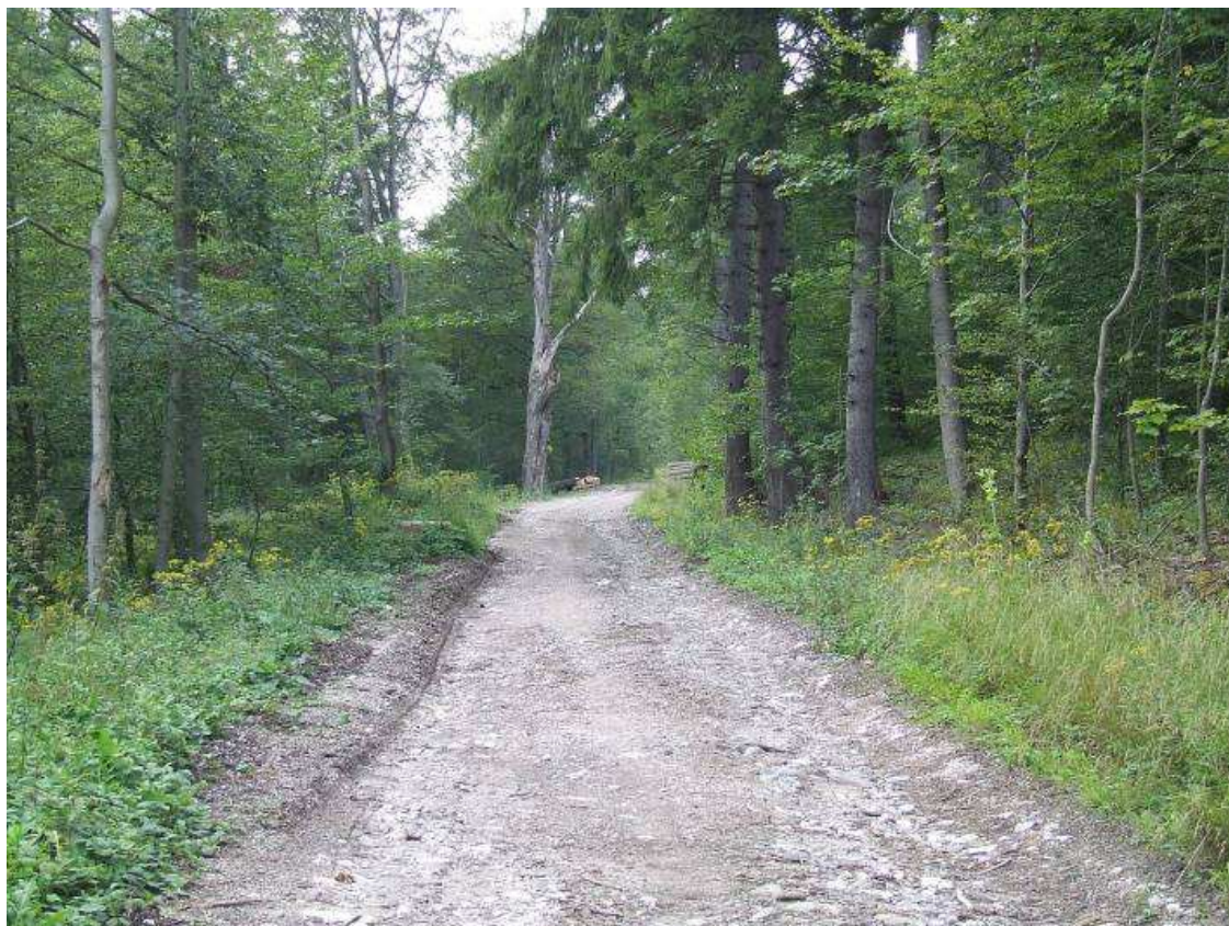
Fot. 3. Widok na drogę przewidziana do remontu; 13.08.2011 (fot. T. Zając)
