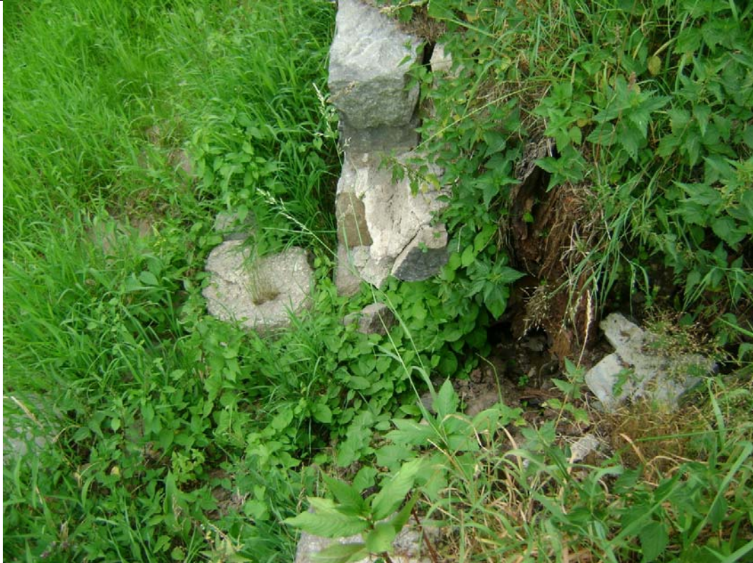
Fot 3 – wyrwa w murze.
