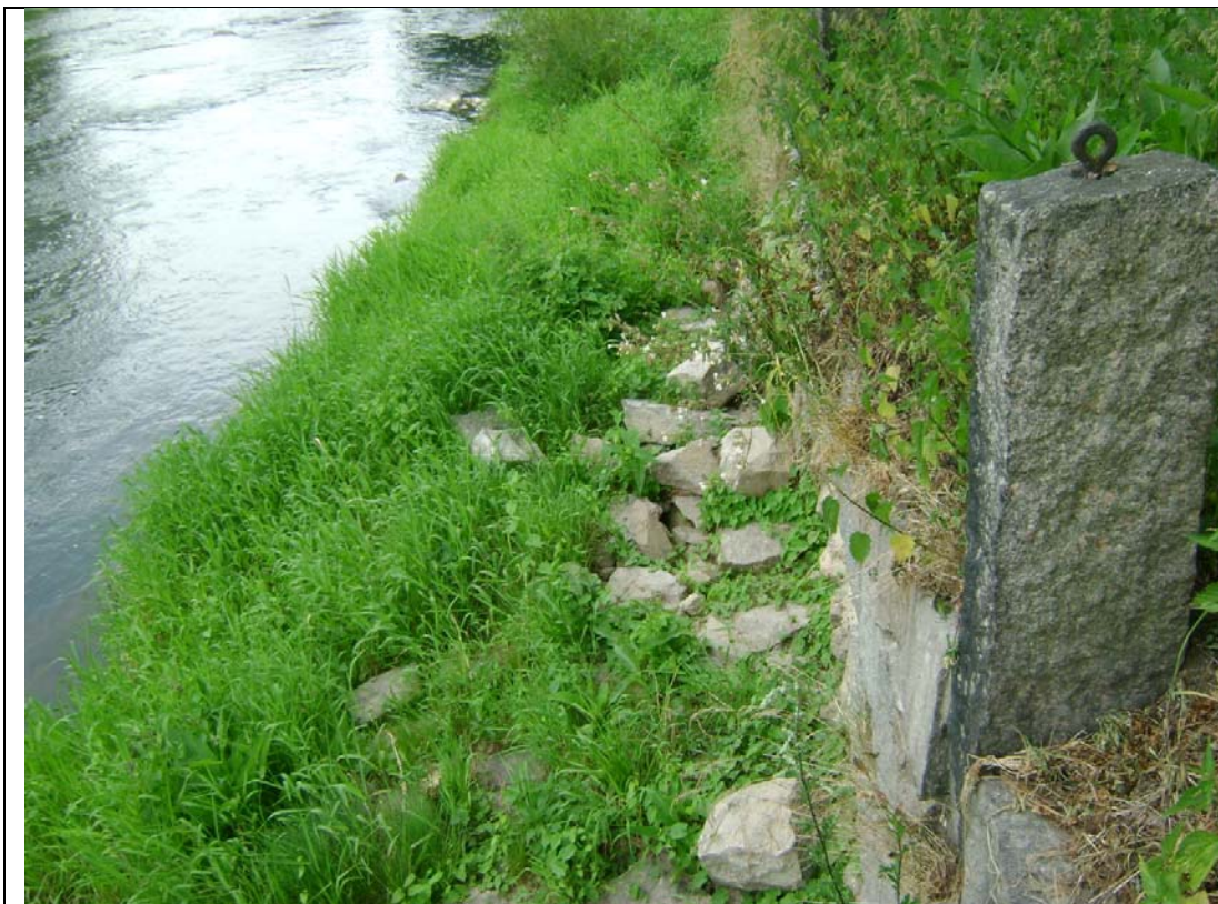
Fot 2 – zniszczony mur i zarośnięta opaska przynurtowa
