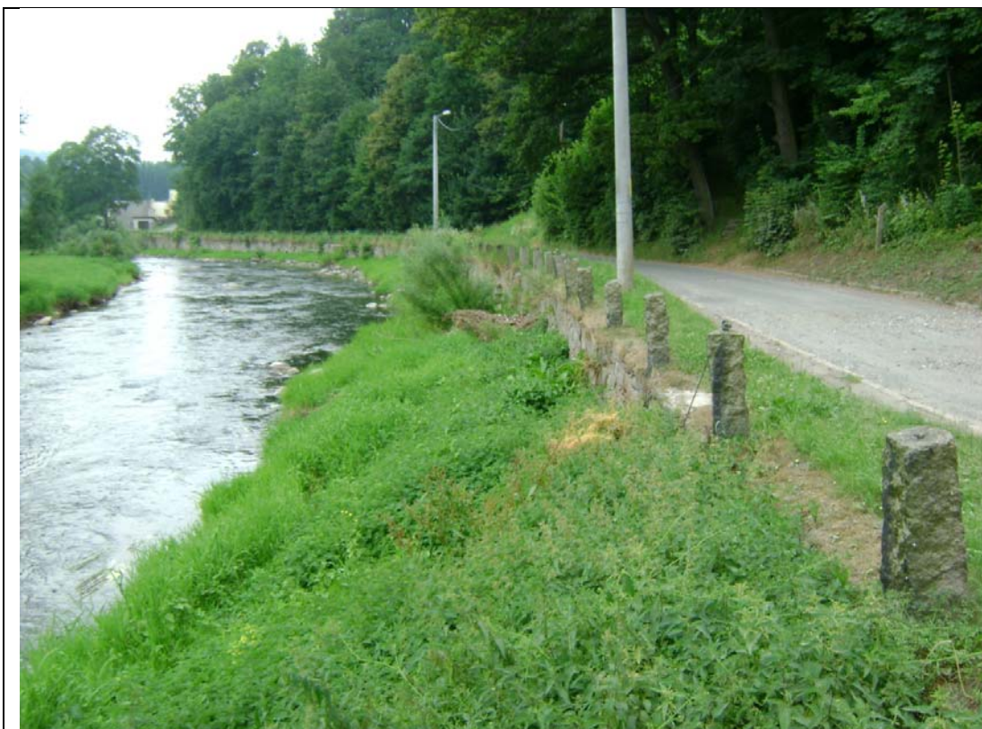
Fot 1. – widok na mur od strony końca odcinka
