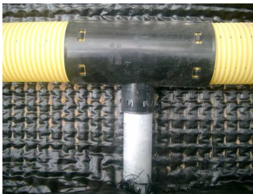
Rysunek 2 Połączenie rury drenażowej \Phi 100\text{ mm} z rurką \Phi 50\text{ mm}
