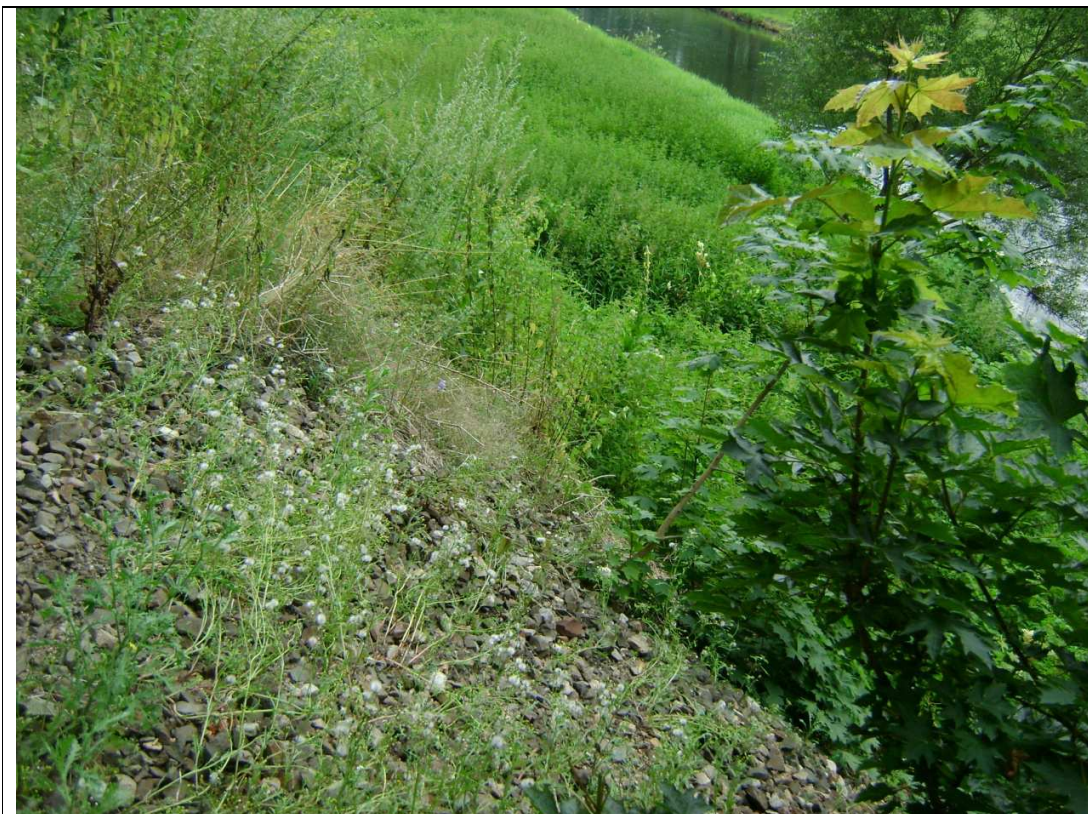
Fot 2 – narzut kamienny na skarpie w miejscu muru
