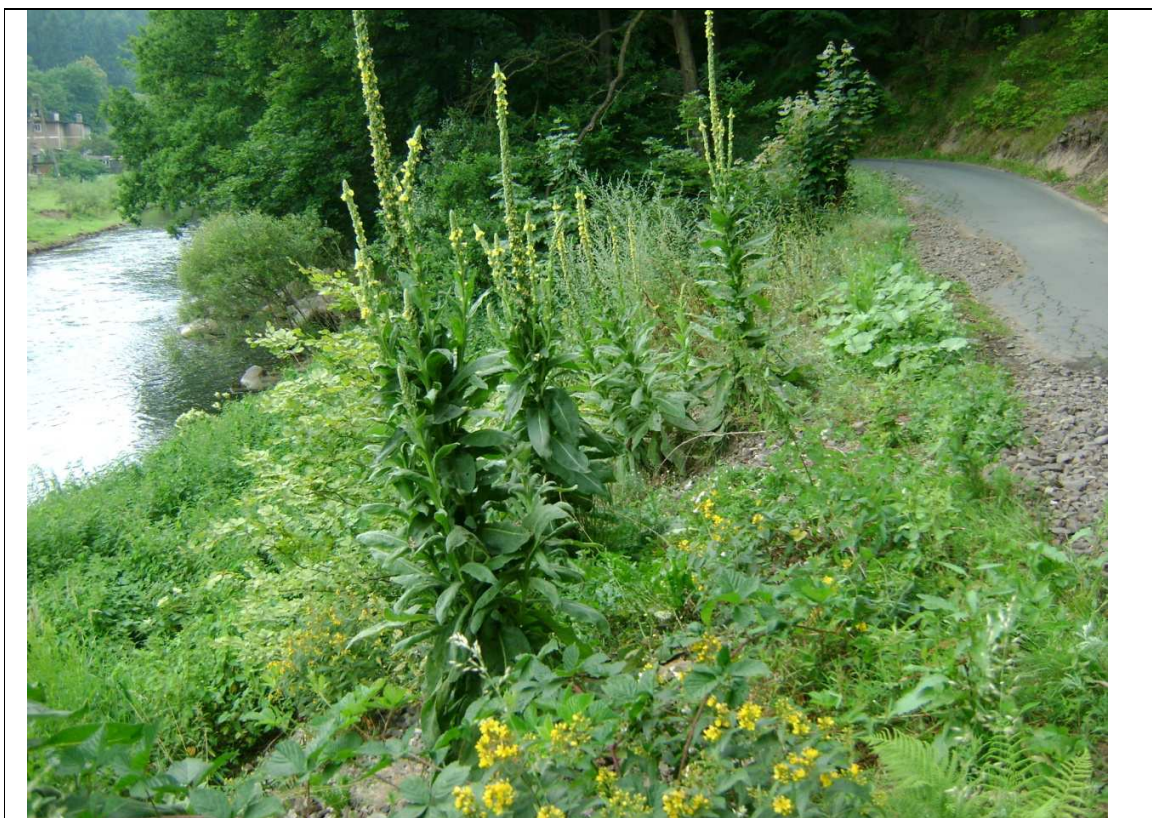
Fot 1. – widok na skarpe. Po lewej stronie widoczna degradacja jezdni.
