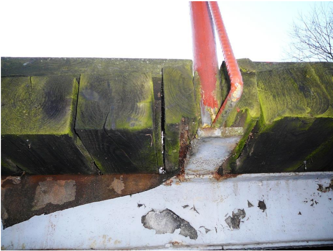
Fot.Nr.7. Korozja dźwigarów stalowych mostu. Korozja biologiczna bali drewnianych jezdni mostu.
