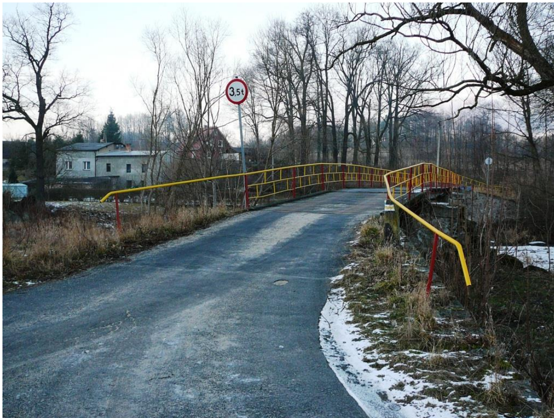
Fot.nr.1. Widok mostu od strony drogi gminnej (działka nr. 354/1)
