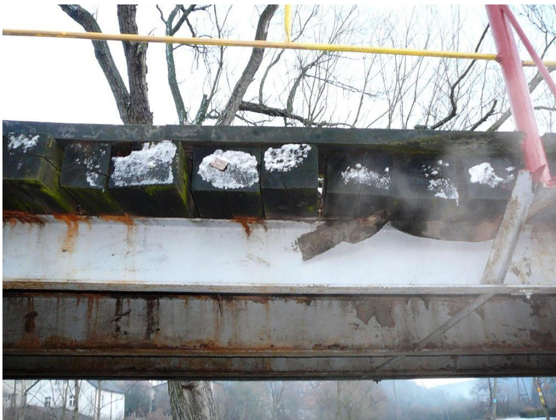
Fot.nr.9. Widok przęsła z boku. Zniszczona izolacja. Korozja stalowych dźwigarów mostu.
