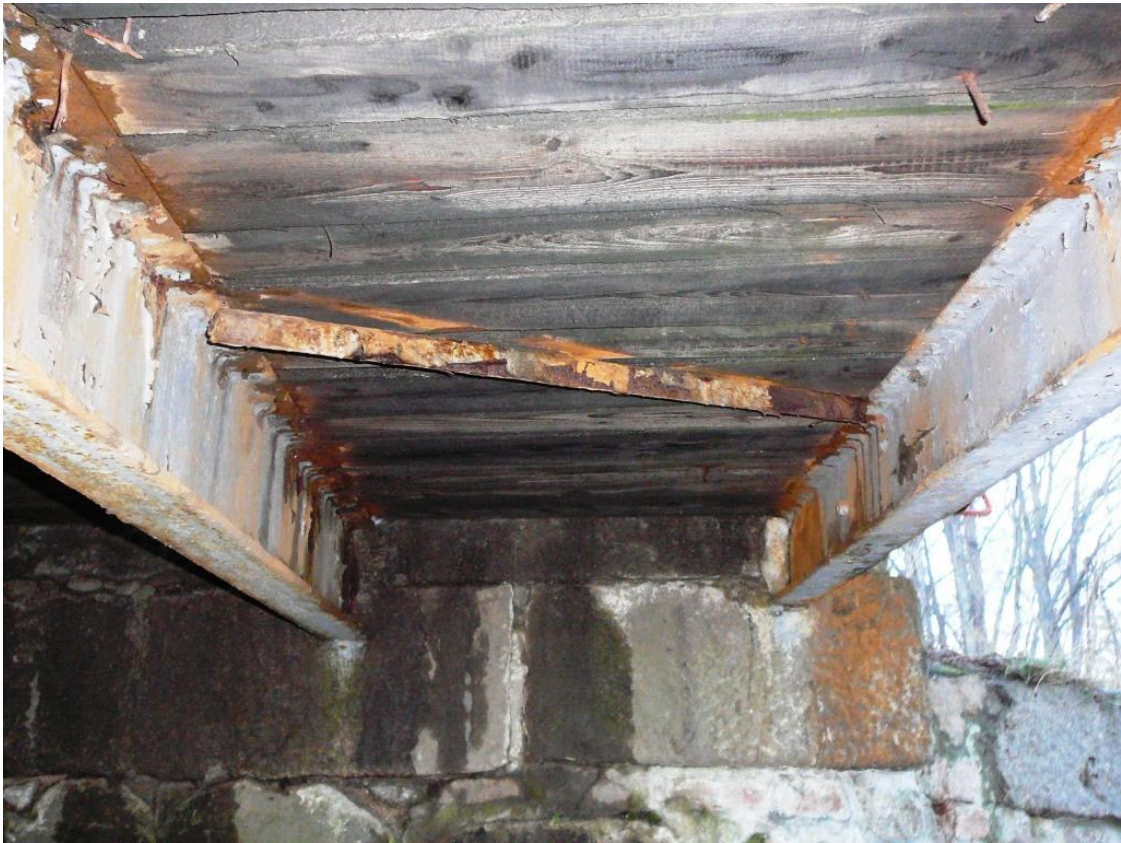
Fot.Nr.8. Widok mostu od spodu. Korozja dźwigarów i stężeń. Korozja biologiczna bali jezdni mostu.
