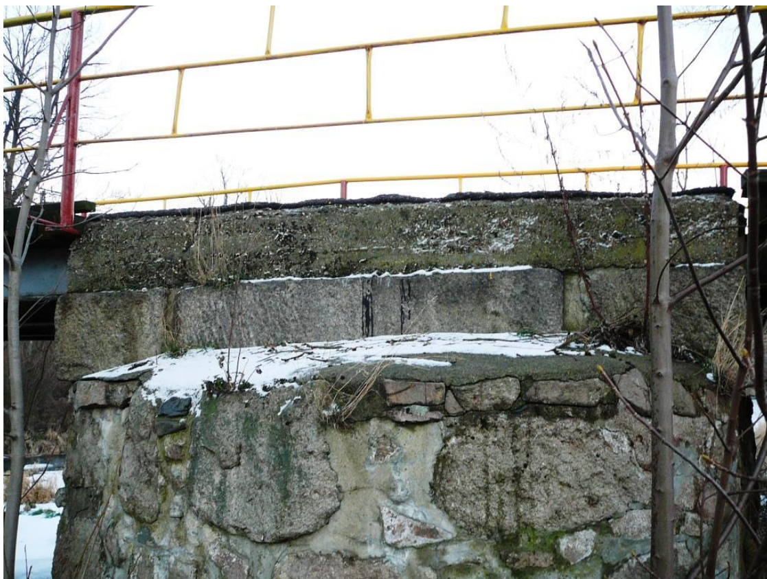
Fot.Nr.11. Widok filaru mostu z boku od strony WD. Zanieczyszczenia biologiczne. Oczepek betonowy - korozja betonu.
