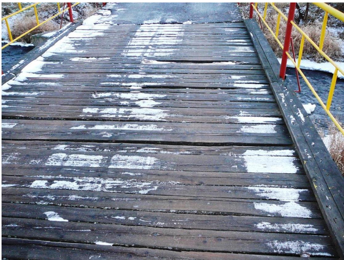
Fot.Nr.4. Widok jezdni mostu z bali drewnianych. Korozja i ubytki materiału. Destrukcja drewna.
