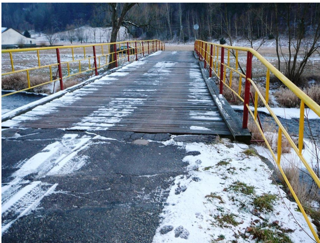
Fot.Nr.3 Wjazd na most od strony drogi powiatowej nr. 2278D. Spękania nawierzchni na wjeździe na most. Ubytki materiału w nawierzchni bitumicznej.
