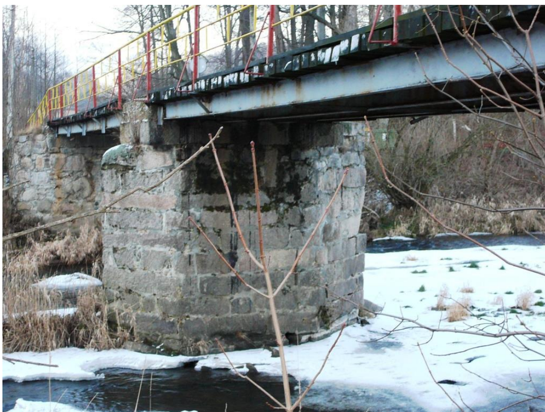
Fot.Nr.10. Filar kamienny nurtowy. Zanieczyszczenia biologiczne bloków kamiennych.
