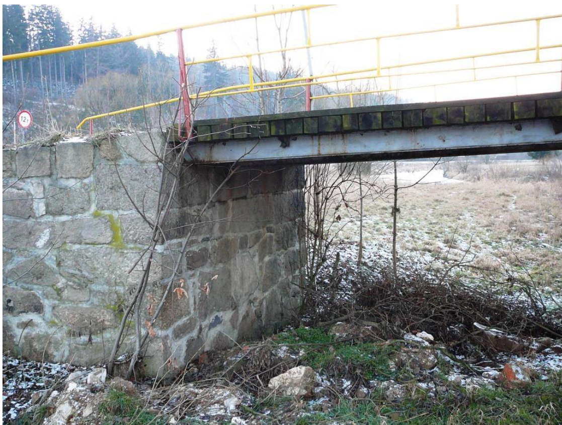
Fot.Nr.6. Widok kamiennego przyczółka lewobrzeżnego. Zanieczyszczenia przestrzeni podmostowej.
