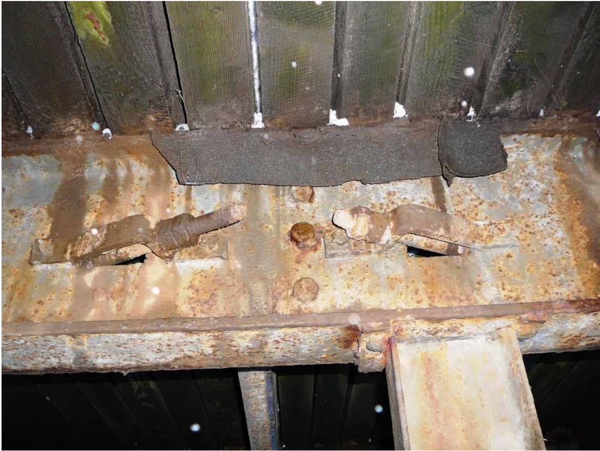
Fot.Nr.9. Widok dźwigara nośnego I NP32 i stężeń wiatrowych . Korozja stali.
