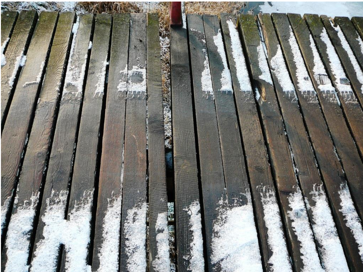
Fot.Nr.6. Widok jezdni mostu. Zmienne szerokości pomiędzy balami. Brak mocowania bali do I NP320.
