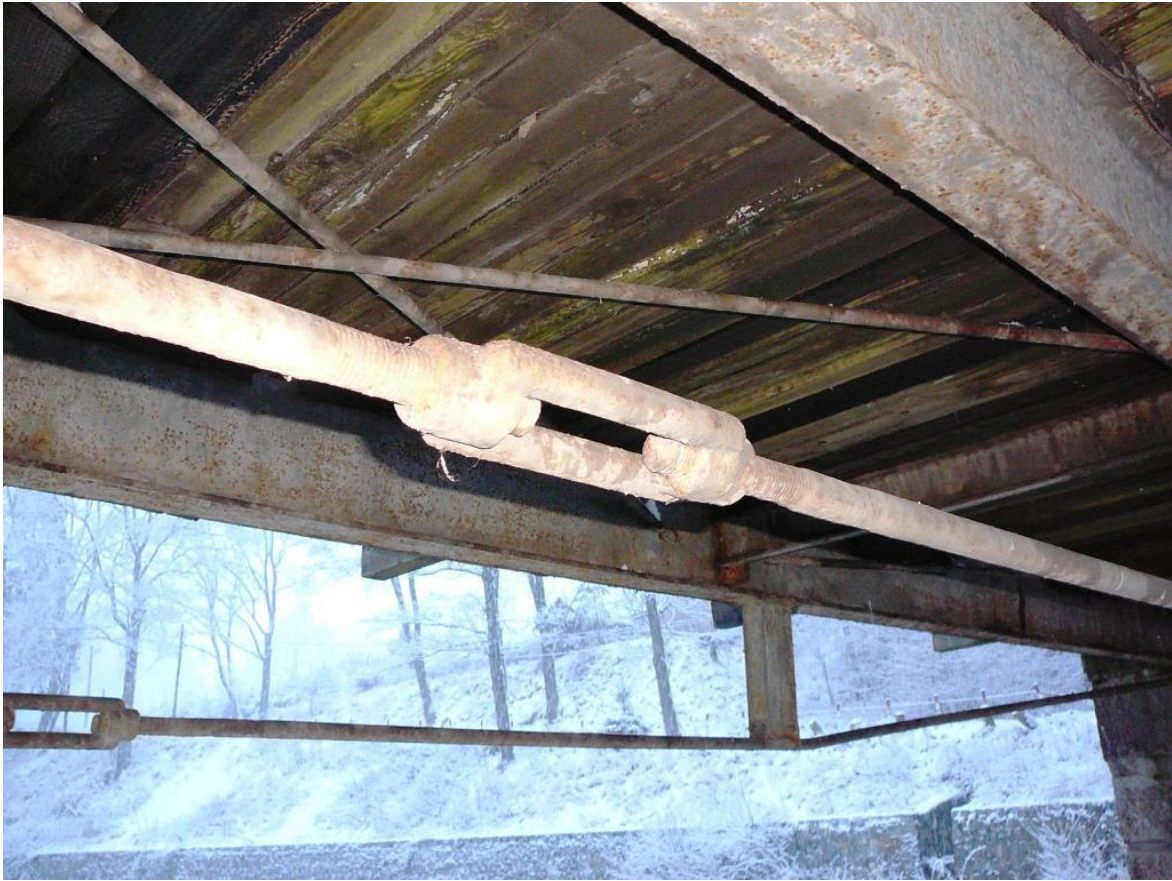
Fot.Nr.11. Widok dźwigarów nośnych I NP320 i stężeń wiatrowych. Korozja stali i bali drewnianych.
