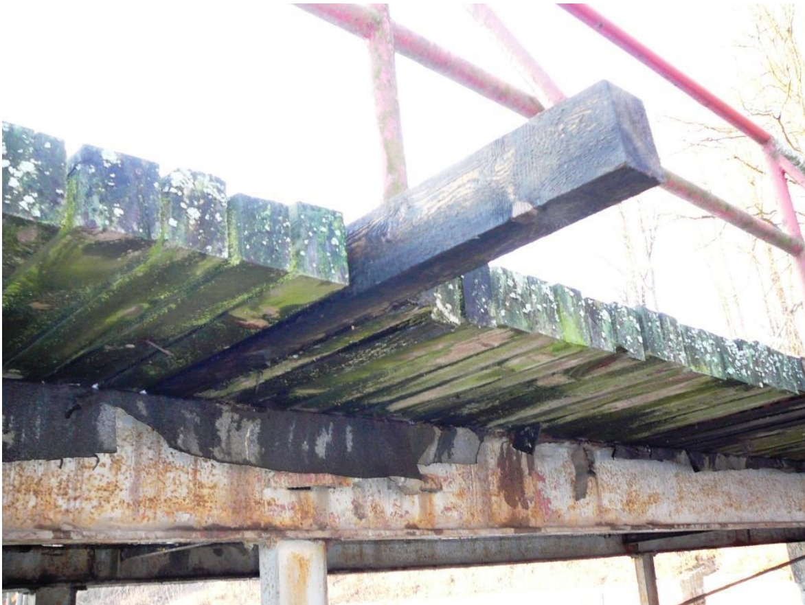
Fot.Nr.8. Widok bali drewnianych jezdni i dźwigarów nośnych I NP320. Korozja drewna i stali.
