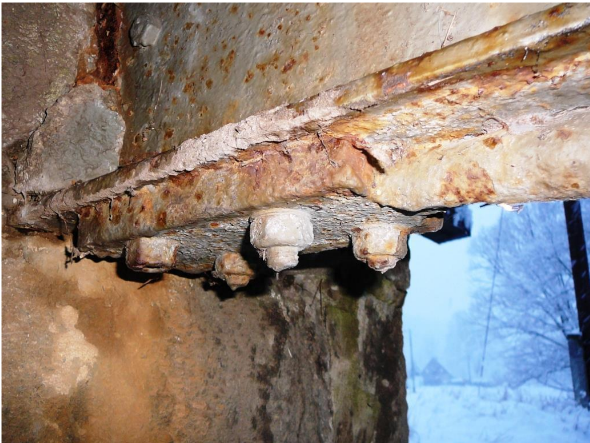
Fot.Nr.10. Widok dźwigara nośnego I NP32 i mocowania stężenia wiatrowego. Korozja stali.
