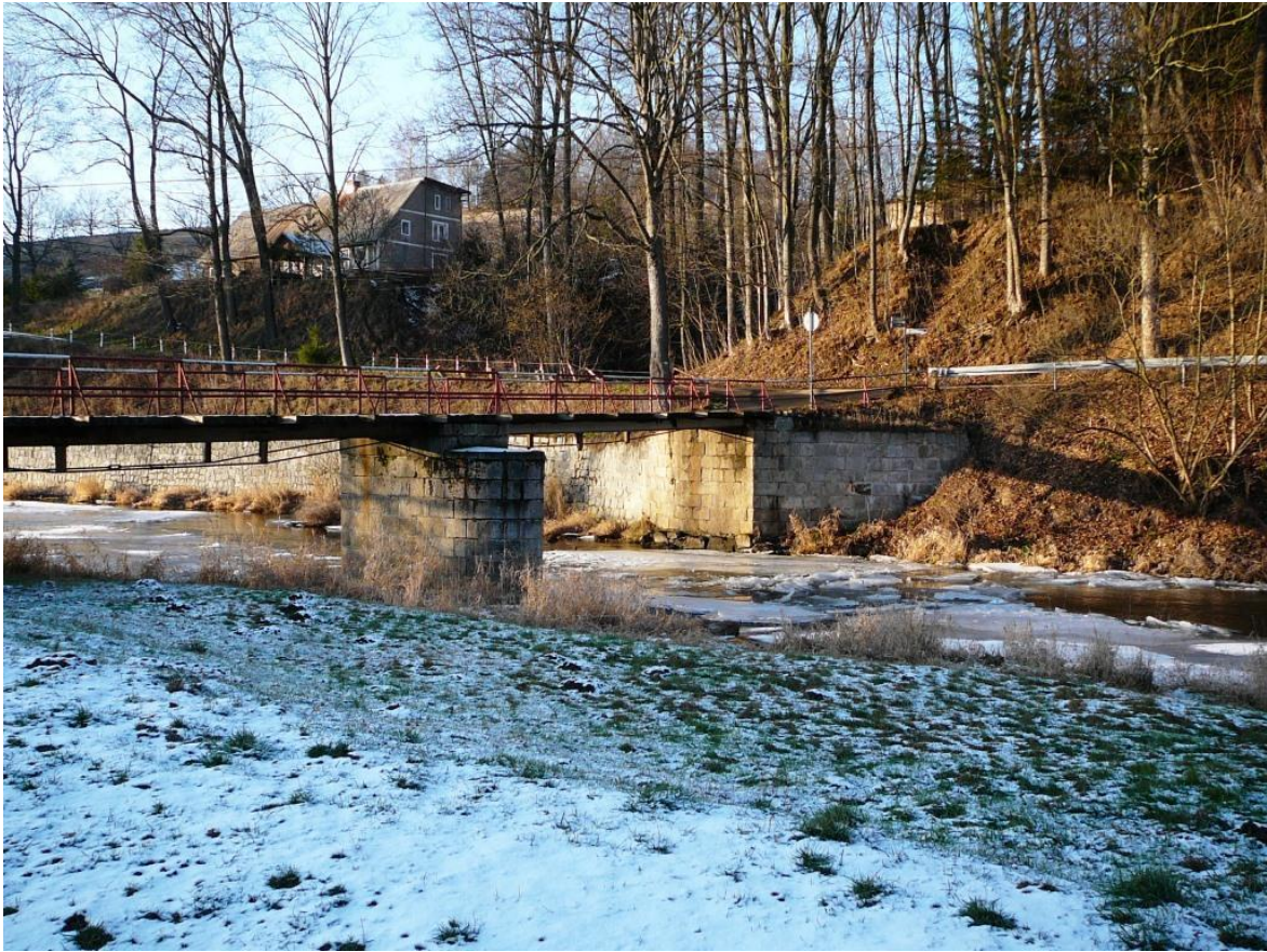
Fot.Nr.5. Widok mostu od strony WG. Brak stężenia wiatrowego w prześle prawobrzeżnym.
