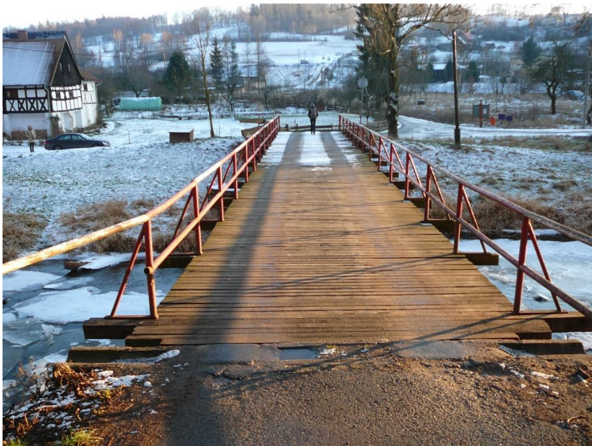
Fot.Nr.1. Widok mostu w planie od strony ul. Partyzantów (droga gminna nr. 114297D)
