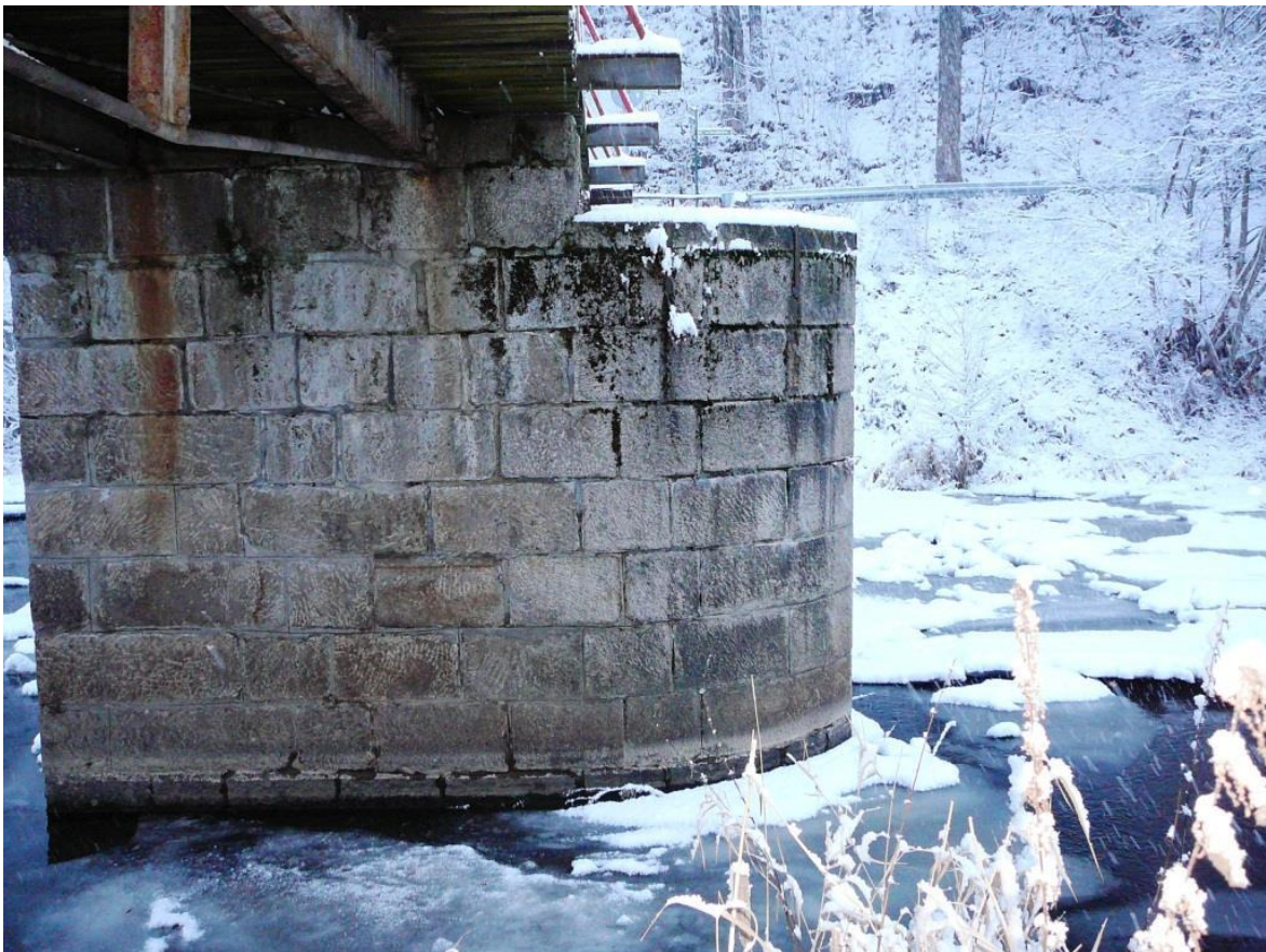
Fot.Nr.12. Widok filara nurtowego kamiennego. Nacieki i zanieczyszczenia biologiczne.
