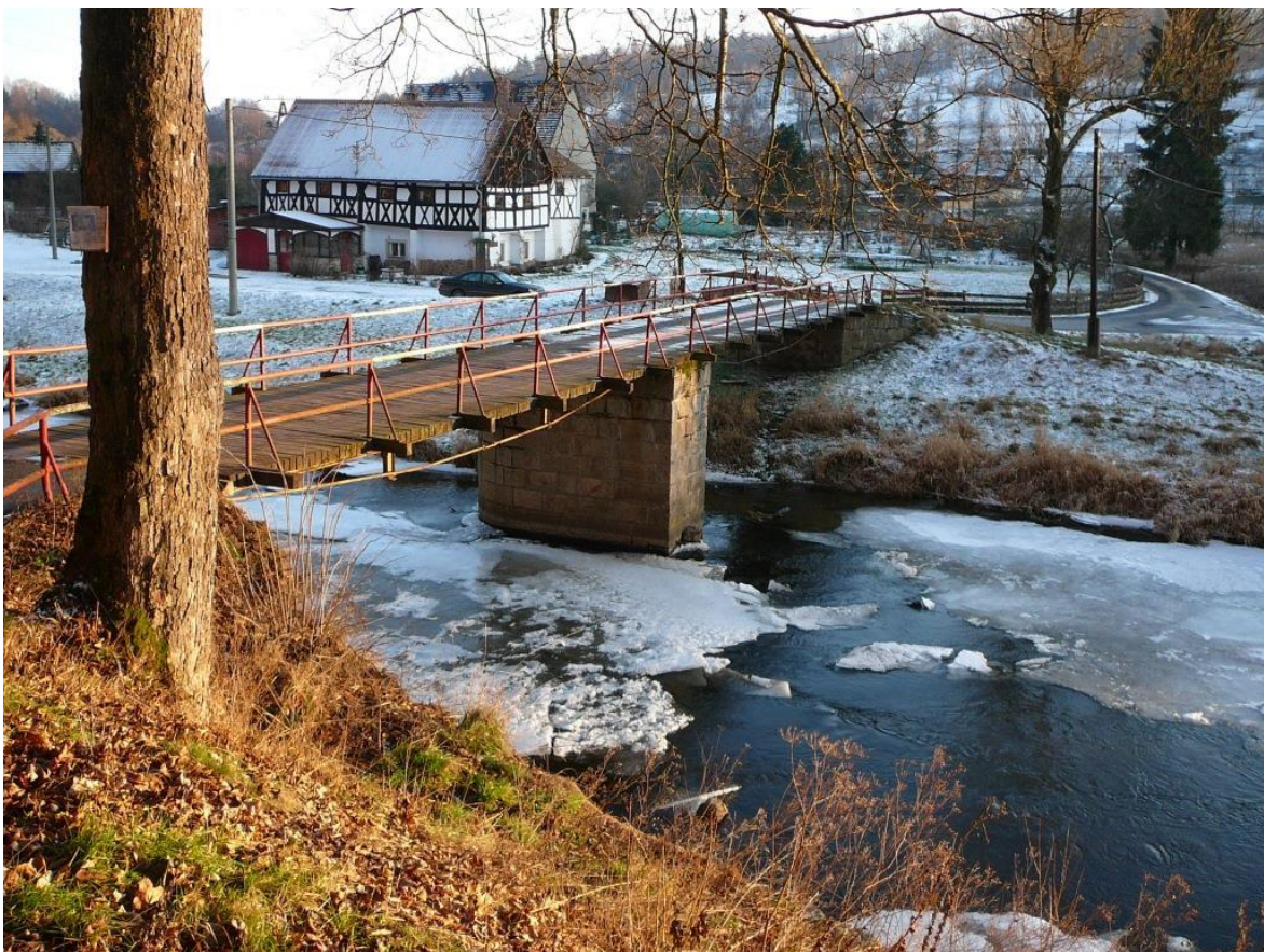
Fot.Nr.4. Widok mostu od strony WD (odpływu).
