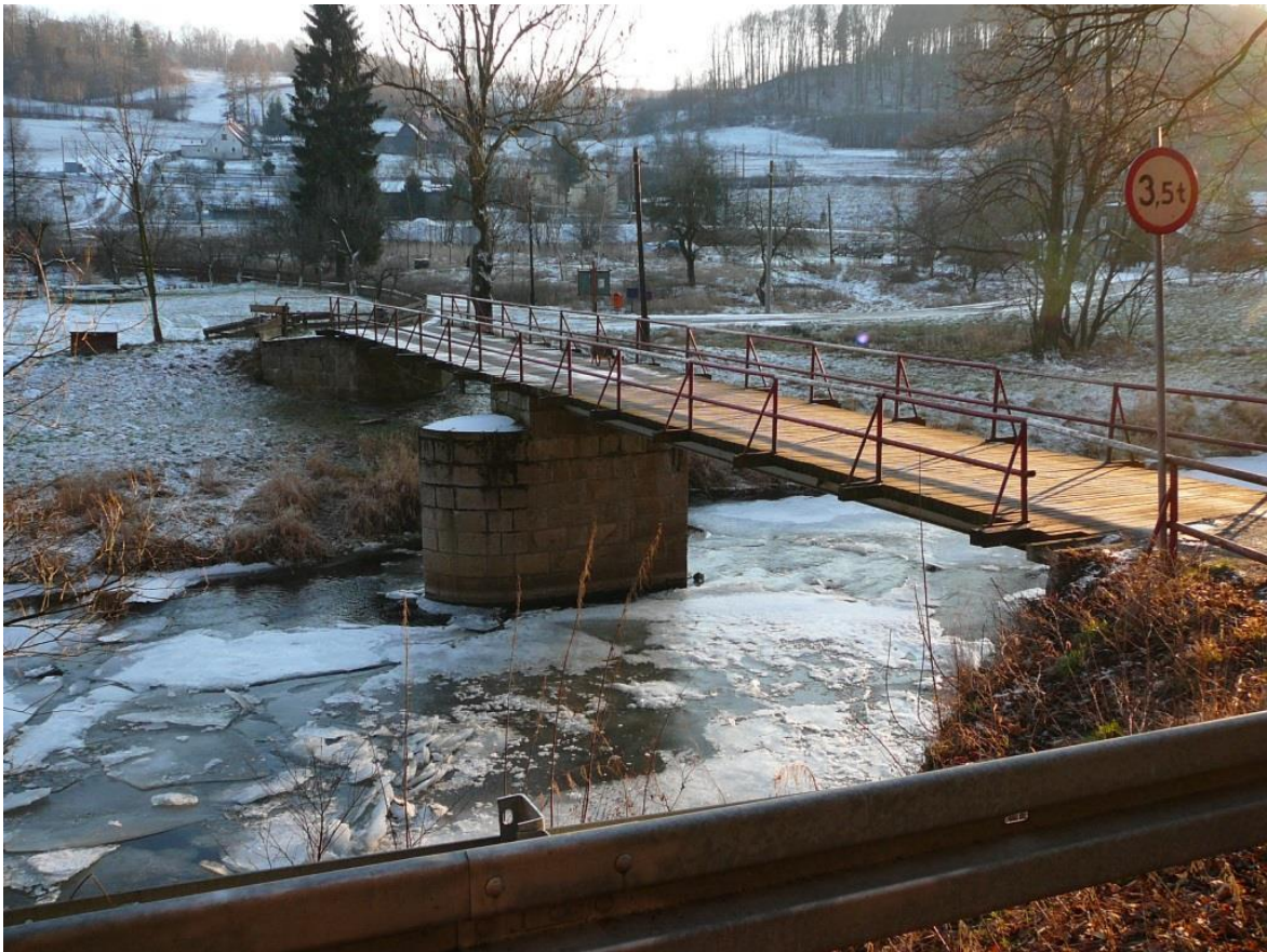
Fot.Nr.3. Widok mostu od strony WG (napływu).
