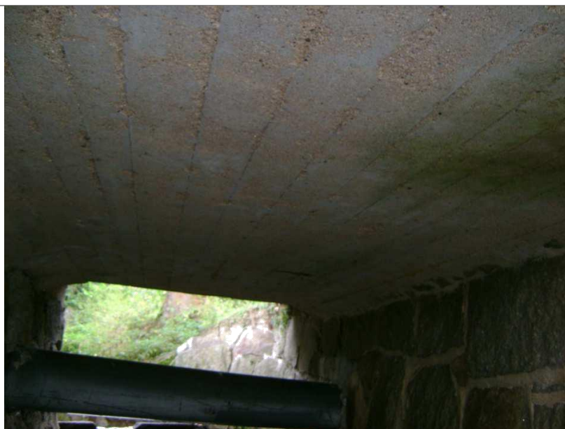
Fot 4 – Widok płyty nośnej przepustu P1
