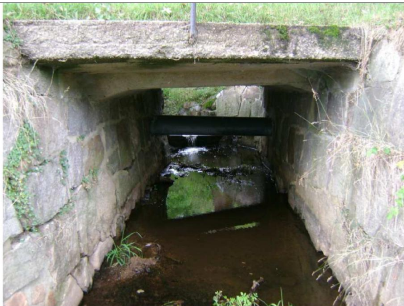
Fot 3 – Widok przepustu P1
