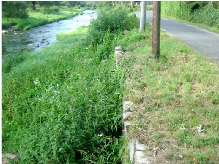
Fot 1 – Mur oporowy – uszkodzona konstrukcja muru w rejonie słupa energetycznego
